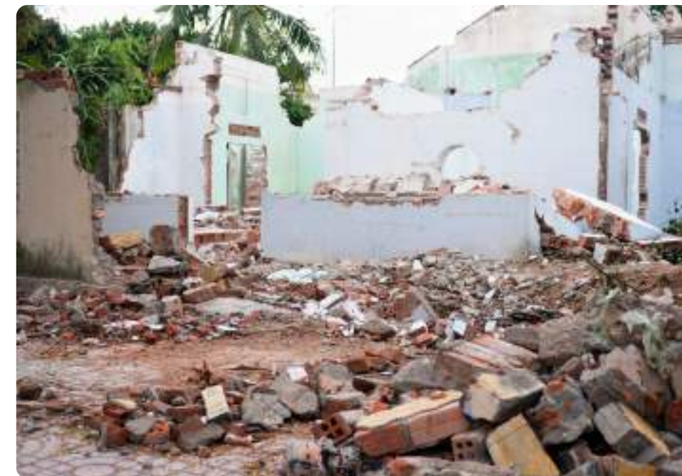
Las casas están demolidas.
